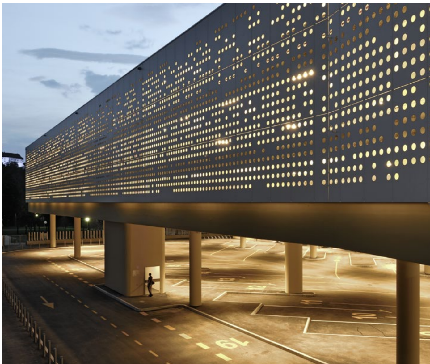
Busstation, Velenje/Slovenien. Largo, Farblinie: Carat. Architektur: Guzic Trplan Arhitekti D.O.O., Ljubljana/Slovenien. Fotografie: Miran Kambic, Radovljica/Slovenien
